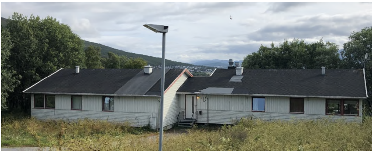
Bilde 10 – Nr. 71 – Tekking på tak
