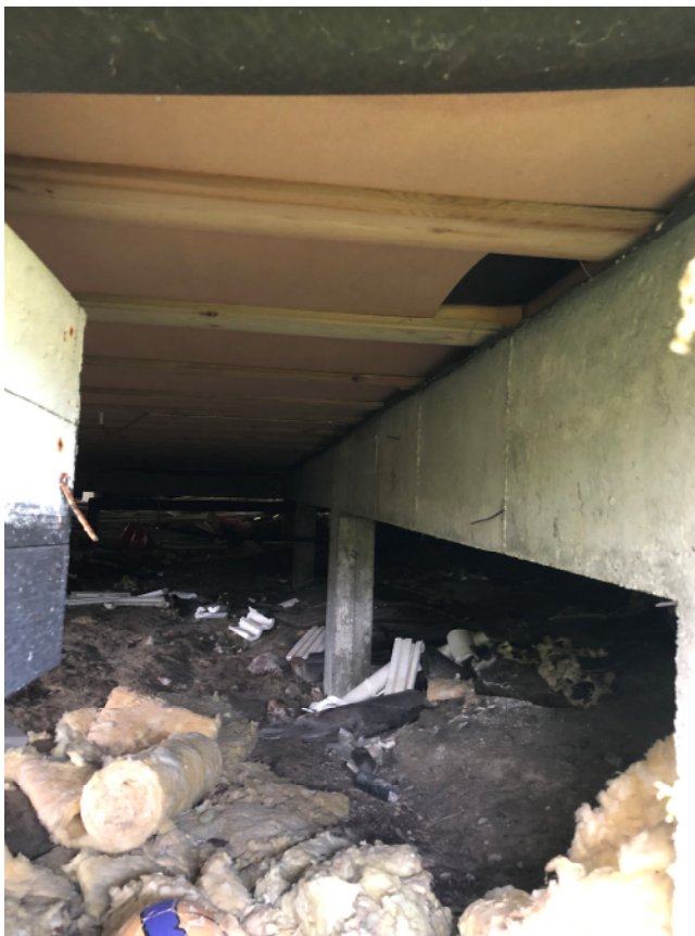
Bilde 14 – Nr. 73 – Kryp kjeller mot nord
