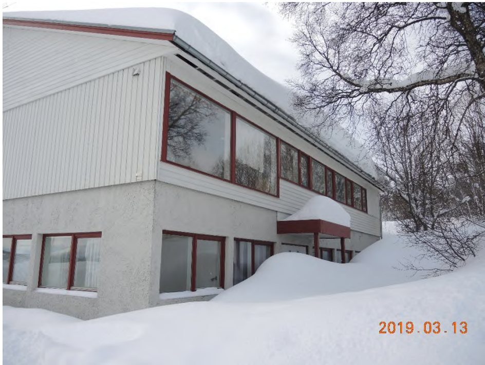
Bilde 3 – Hovedbygning Fasade mot nord.
