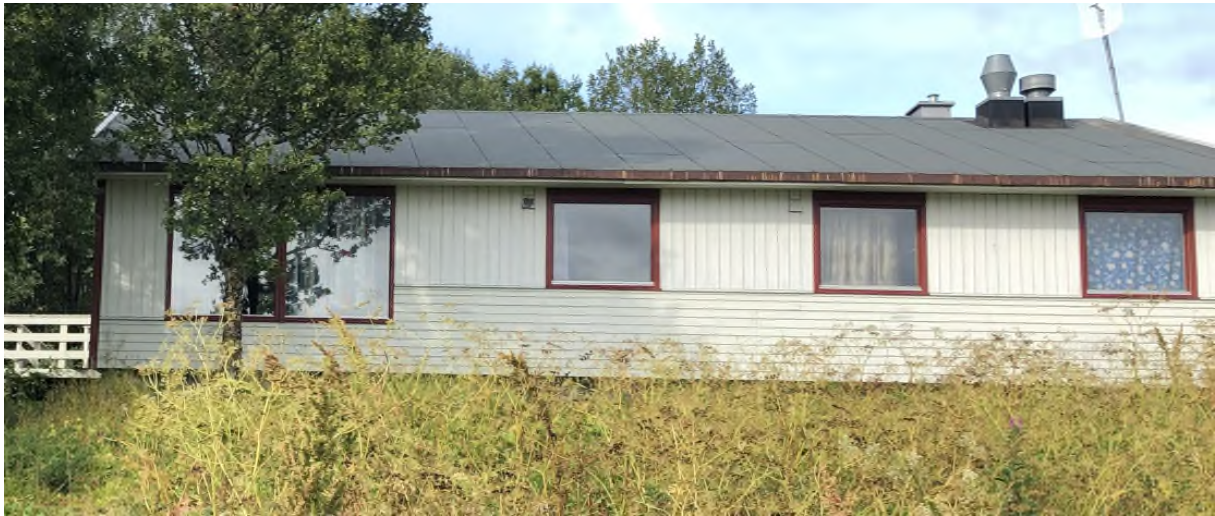
Bilde 11 – Nr. 67 – Tekking på tak
