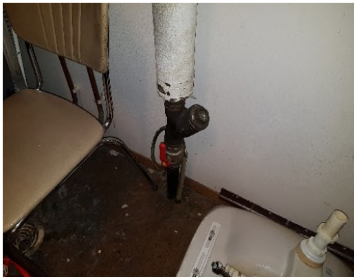
Figur 1: Vanninnlegg m/Filter og stoppekran 65
