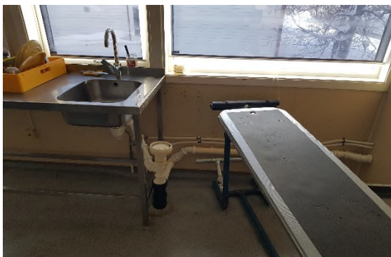
Figur 7: Avløps-ledninger storkjøkken
