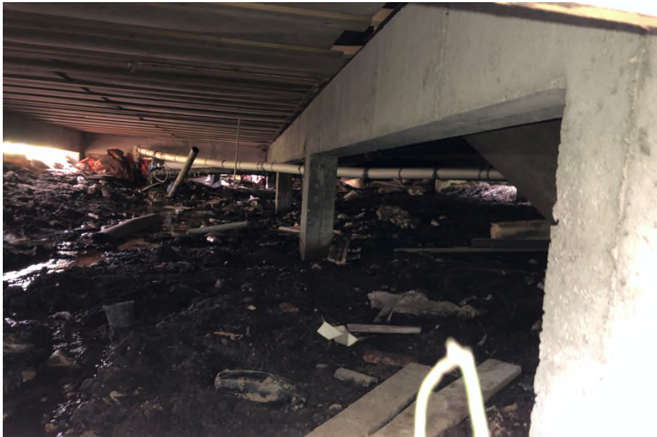
Bilde 13 – Nr. 69 – Kryp kjeller mot nord
