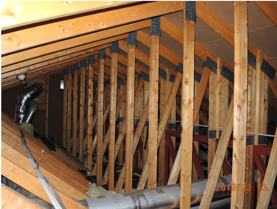
Bilde 5 – Hovedbygning loft – W-takstoler og fagverksdrager i stål.
