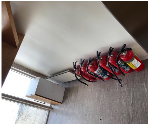
Bilde 9.4.2 – Slokkeapparater plassert under trapp.
