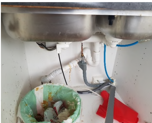
Figur 8: Avløps-ledninger nyetablert kjøkken i plan 1
