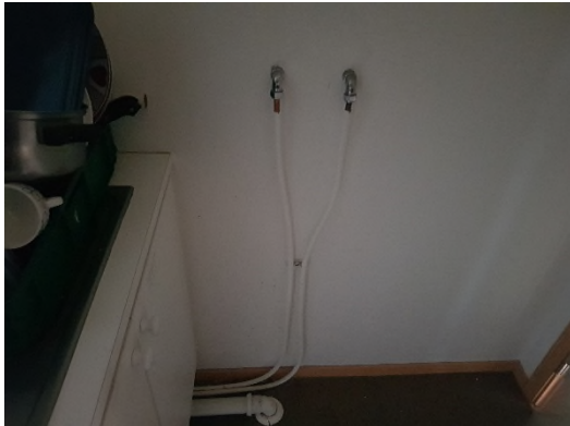
Figur 5: Forbruksvann og avløps-ledninger
