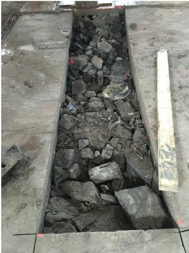
Figur 5-2 Eksisterende drensmasser under gulv på grunn- Bygg 7
