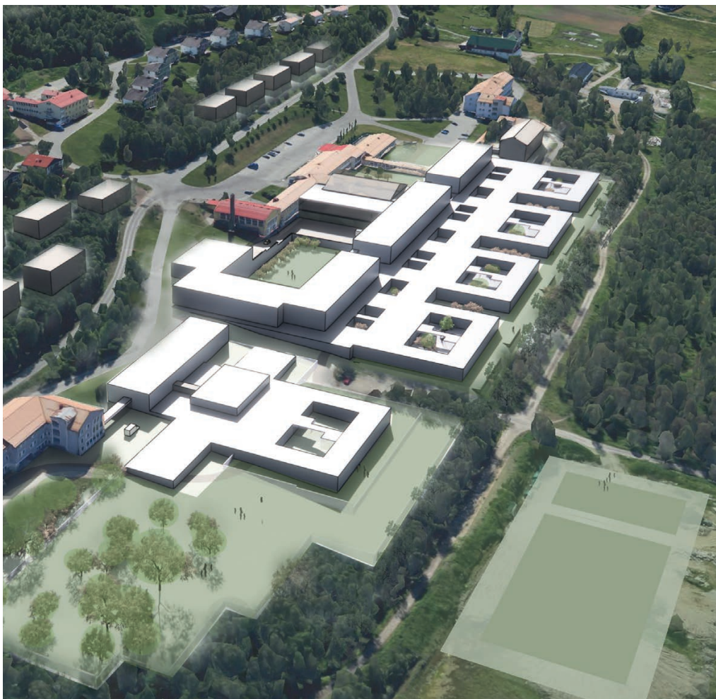
Åsgård Å3 mot nord
